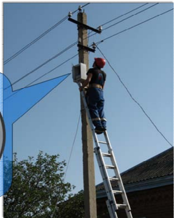
Рисунок 5 Примеры установки концентратора в защитном корпусе на месте
